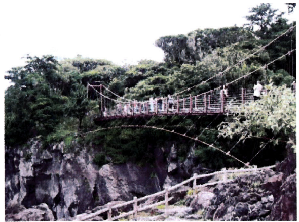
城ヶ崎北端の迫力満点の人気スポット・門脇吊り橋
