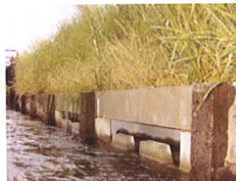
岐阜県の魚巢ブロック施工例
